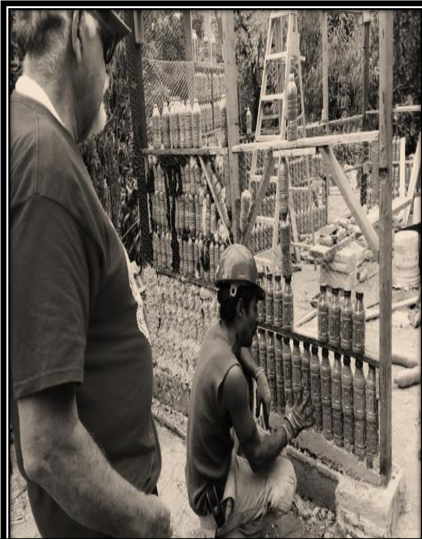
Foto 24. Reconstrucción de vivienda con pet y materiales locales en el Municipio de Ocuiluco, Morelos.
